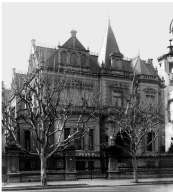
Av. Alvear 1845. Petit hotel de los Drysdale, luego embajada británica en la década del '20. Foto en Tartarini (2017).
