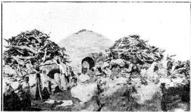
Foto 2. — Un horno para la fabricación del carbón. Las dos chicas que se ven en segundo plano, están cosiendo bolsas y se han puesto negras con el polvo de carbón.
