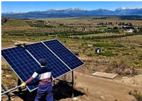
Colocación de los paneles solares en el Barrio Sustentable.
